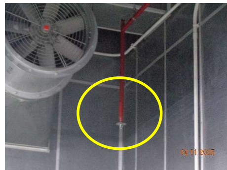
ภาพที่ 2.2-28 หัวกระจายน้ำ (Sprinkler)
