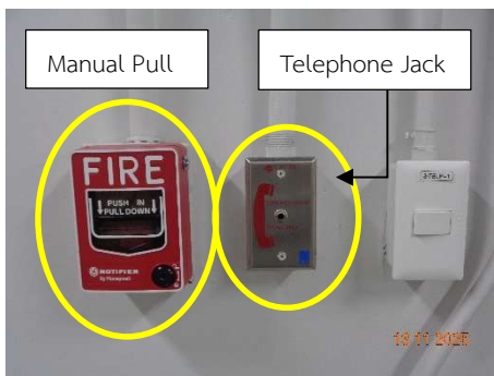
ภาพที่ 2.2-40 อุปกรณ์แจ้งเหตุด้วยมือ และโทรศัพท์มือถือฉุกเฉิน
