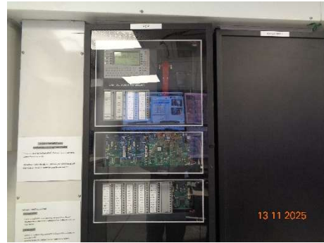
ภาพที่ 2.2-59 แผงควบคุม (Fire Alarm Control Panel : FCP)
