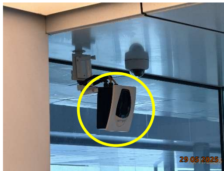
ภาพที่ 2.2-60 อุปกรณ์ตรวจจับควันชนิดลำแสง (Project Beam Smoke Detector Receiver)
