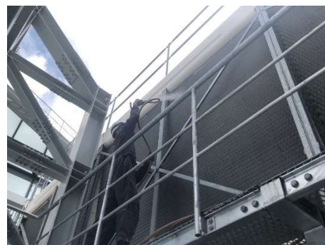
ภาพที่ 2.2-22 เจ้าหน้าที่ส่วนช่างดูแลความสะอาดในหอผึ่งเย็น (Cooling Tower)
