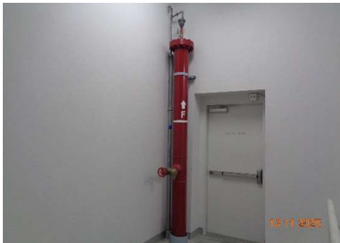
ภาพที่ 2.2-25 ระบบท่อยืน (Stand Pipe)
