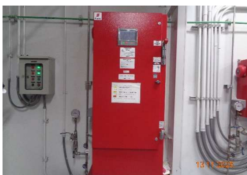
ภาพที่ 2.2-31 เครื่องสูบน้ำดับเพลิงแบบไฟฟ้า
